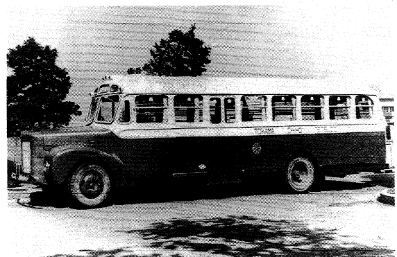
図5 低床式バスKB3B(KD3エンジン搭載)(1948年)
